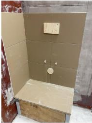
Wc tegelen halfsteens met binnenhoek, vloer en kimband
