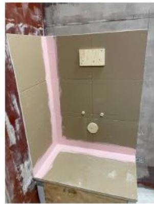
Wc tegelen halfsteens met binnenhoek, vloer en kimband
